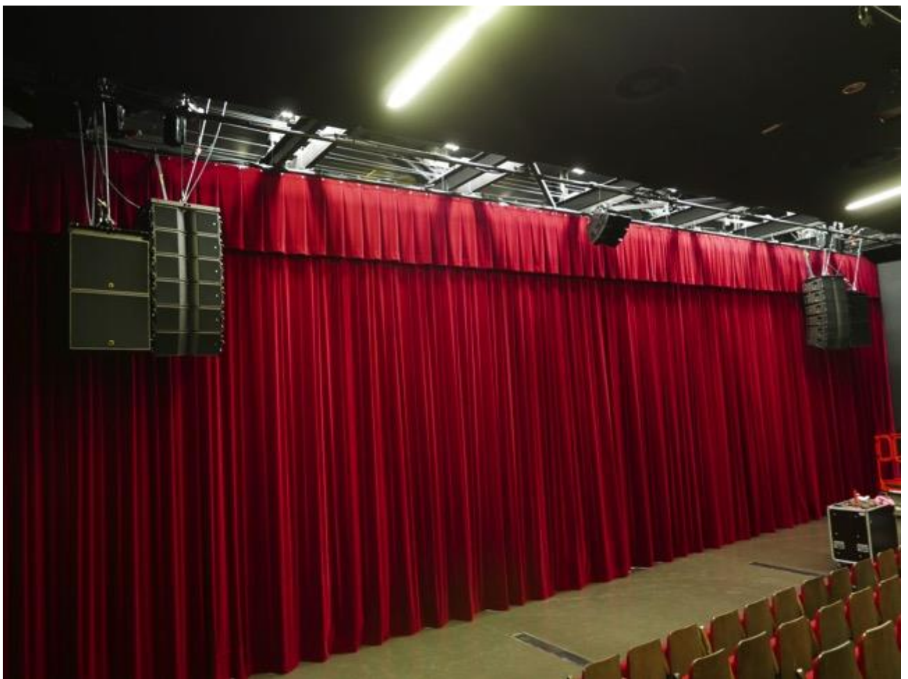
Diffusion façade, 6 x Karas + 2 SB 18 / côté et 3 x Kivas au centre.
